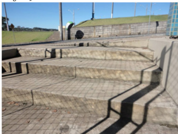
Fotografia 3 – Escada de acesso do local C
