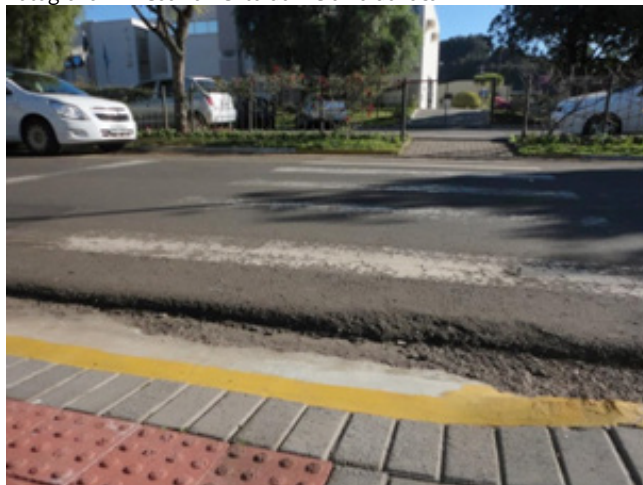
Fotografia 1 – Rebaixamento do meio fio do local A
