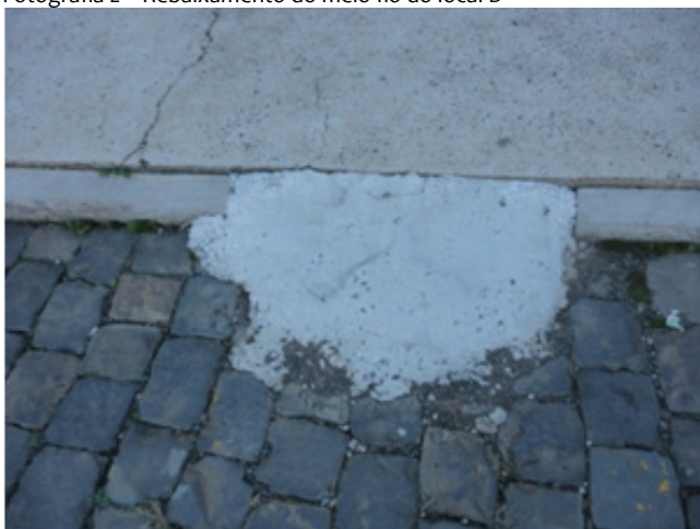
Fotografia 2 – Rebaixamento do meio fio do local B
